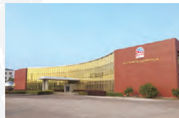
安速日用化学 (蘇州) 有限公司 (アース製薬株式会社蘇州工場)
