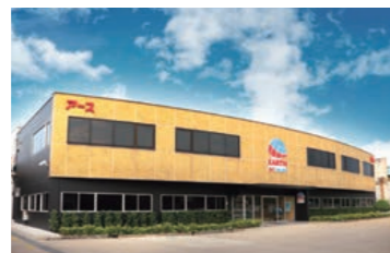
アース タイランド ナワナコン工場 第1工場、第2工場
