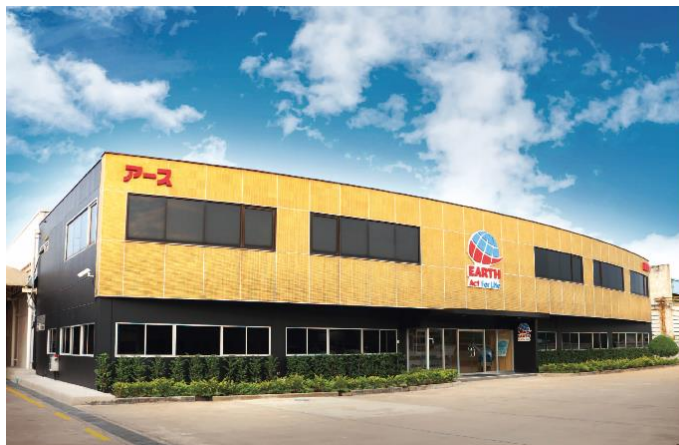
※写真は第2工場 事務所・品質管理棟
