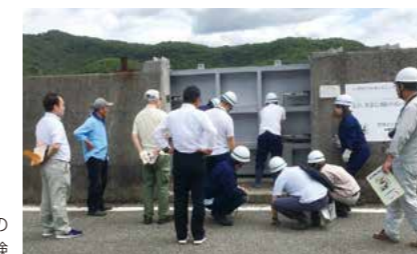
防潮堤の 開閉訓練・点検
