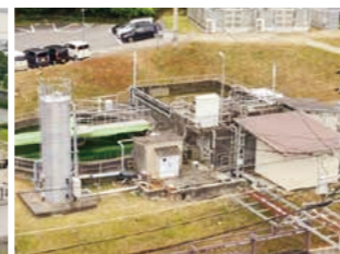
坂越工場 排水処理施設
