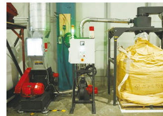
粉碎処理に使用する粉碎機
